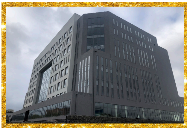
Выполнены работы над «Административным зданием ИФНС России по Кемеровской области»
